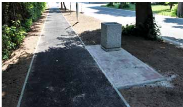
Rekonstruovaný chodník v ulici V Lipkách.
