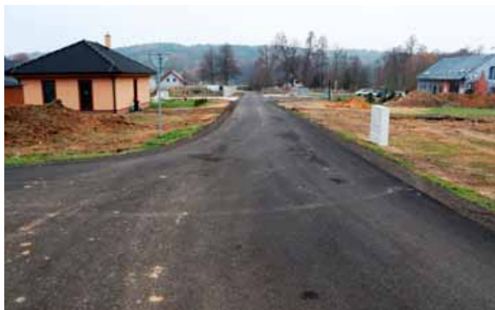
Proběhla oprava komunikací na Bechově.
