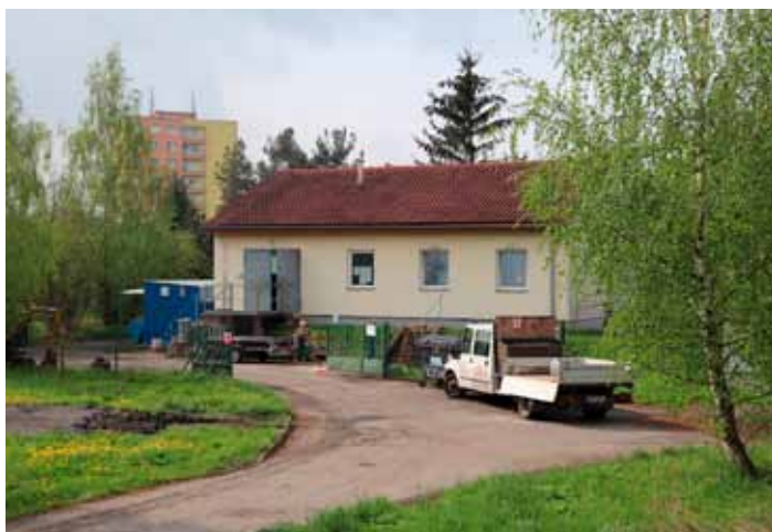
Probíhá intenzifikace čističky odpadních vod.
