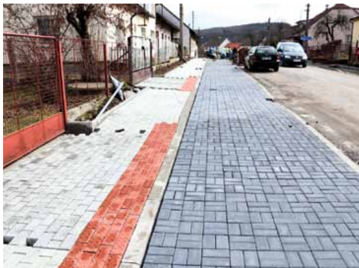
Nové chodníky a parkovací stání konečně vznikají v ulici na Zahradkách.
