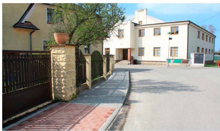
březen – oprava chodníků v ulici Nádražní
