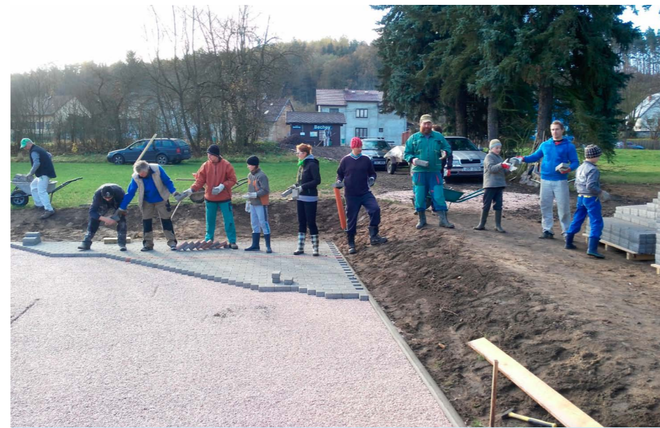
Pokládka zpevněné základny pro požární útok
