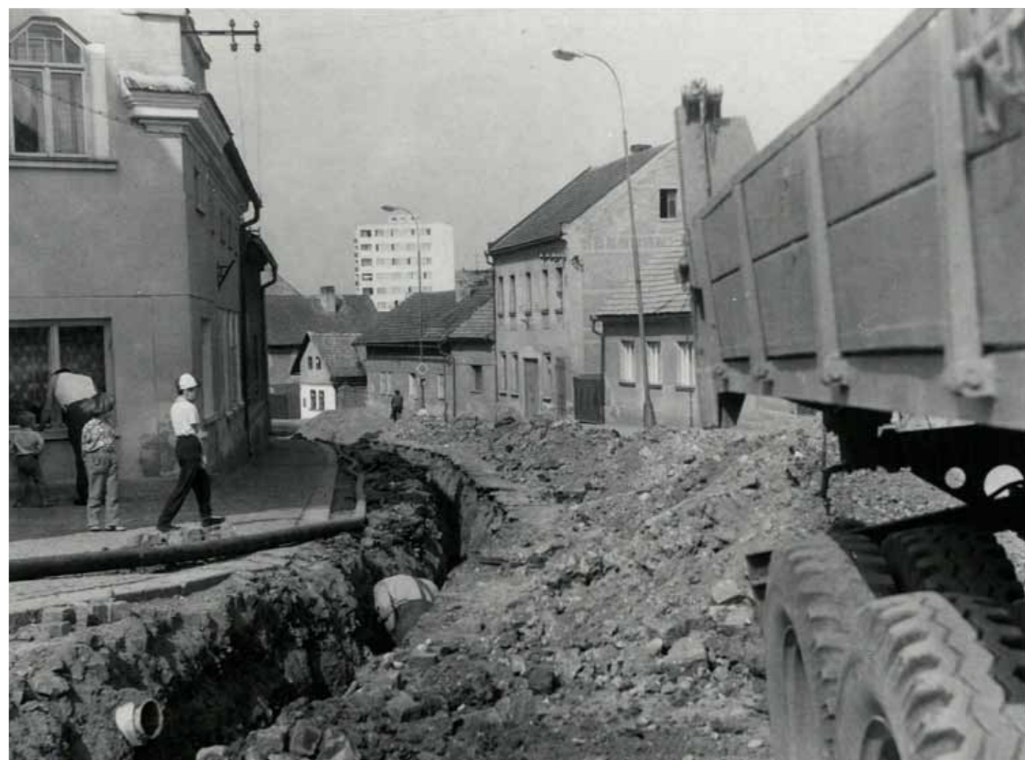
Pokládání vodovodního potrubí v Brodecké ulici.
