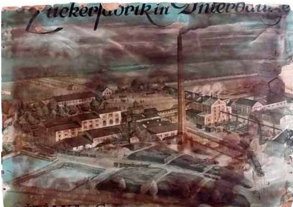
Letecký pohled na cukrovar - obraz z let těsně po jeho založení, cca kolem r. 1880 - ještě před přístavbou administrativní budovy s vodojemem.
