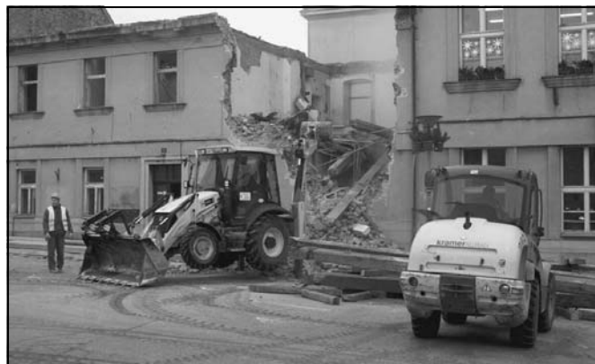
V lednu se do objektu bývalé pošty na dolnibousovském náměstí zakouzl bagr a začala její demolice.
