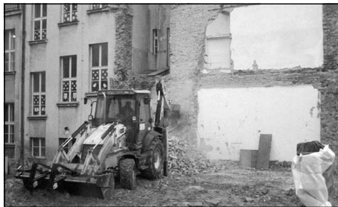
Po několika týdnech zůstala jen proluka, nabízející poprvé v historii zajímavý pohled na budovu školy.
